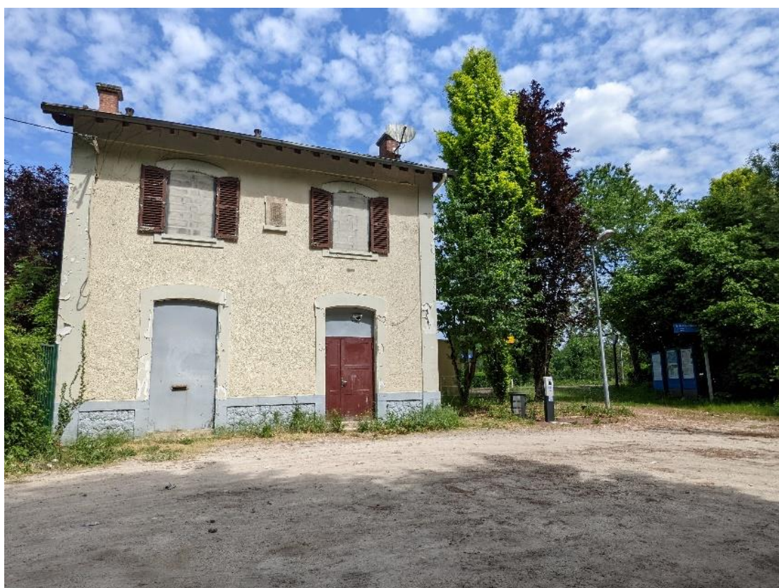
Le bâtiment voyageur muré en gare de Vosves (77) en 2022. Crédit : Stéfan Bove/ L'Institut Paris Region
